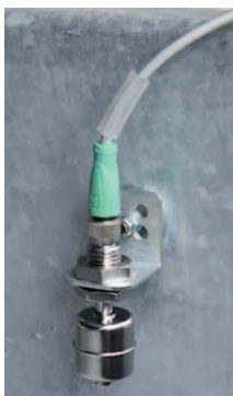
Snímač hladiny zastaví plnění
